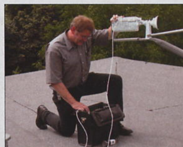
Das LNB muss genau justiert werden, da sonst die horizontale und vertikale Polarisation nicht sauber voneinander getrennt werden kann
