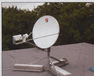
Die Satellitenschüssel mit einem Durchmesser von 98 cm wird auf den Satelliten Atlantic Bird 8° Ost ausgerichtet
